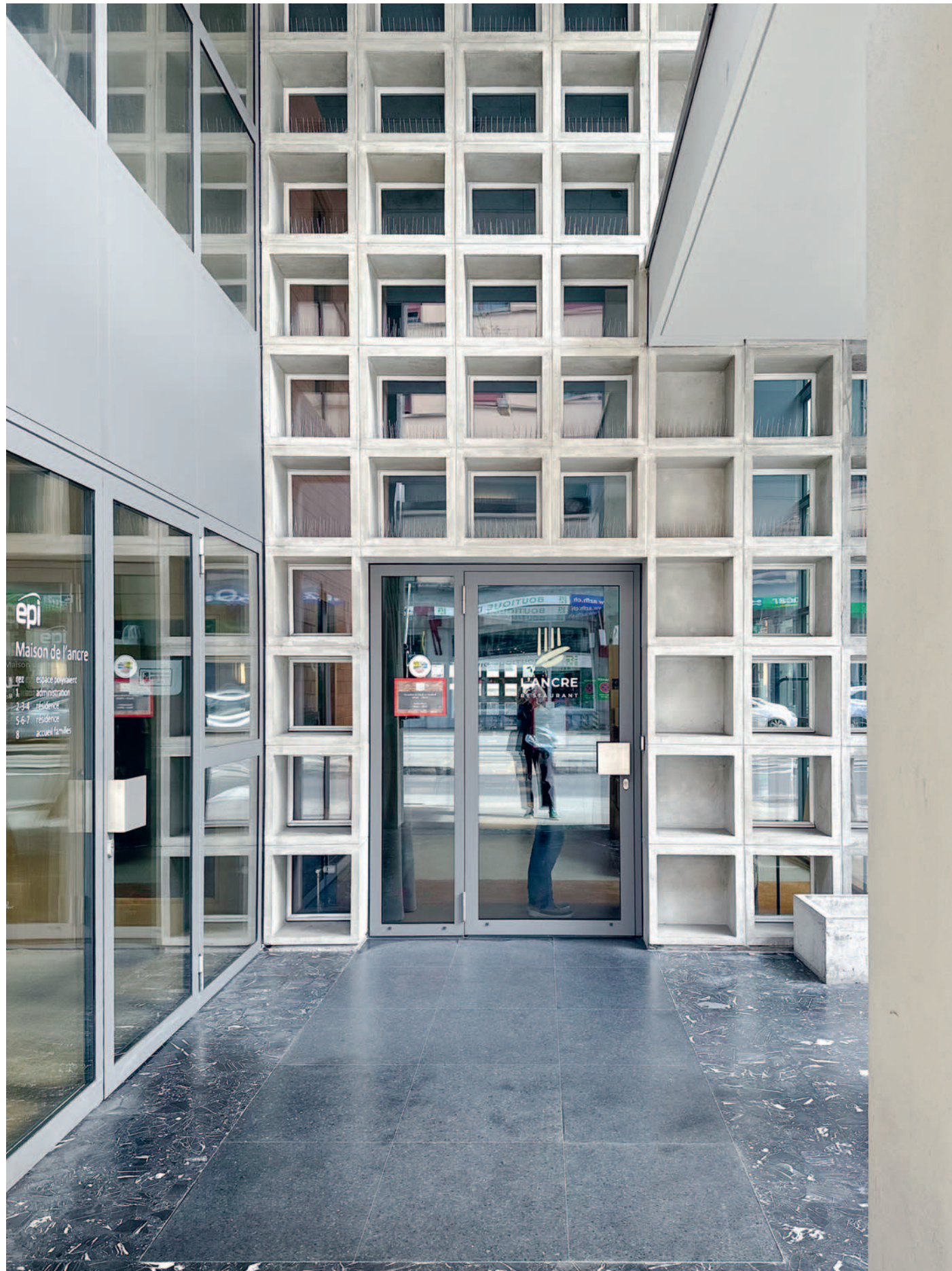
Double hauteur extérieure
